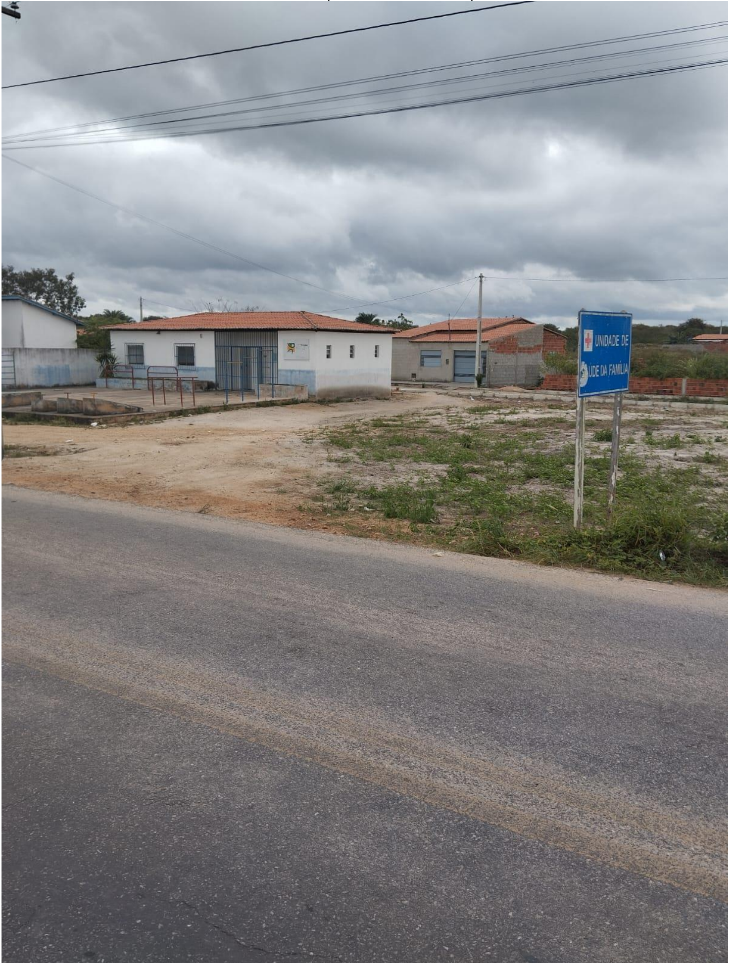
AREA DE CONSTRUÇÃO
