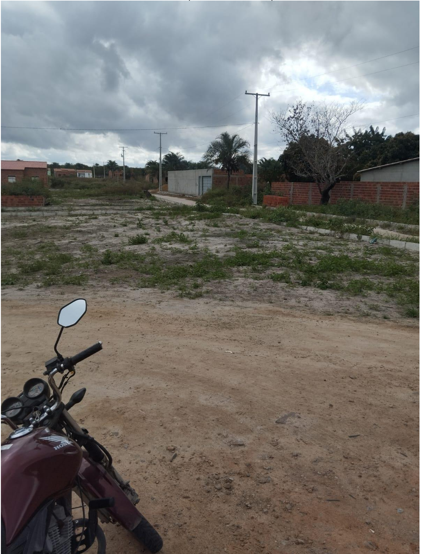
AREA DE CONSTRUÇÃO
